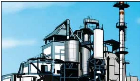
Estas plantas incineran los residuos con poder calorífico, y con ello producen energía eléctrica.
